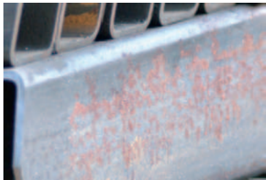
прямоугольная стальная труба перед пескоструйной очисткой
